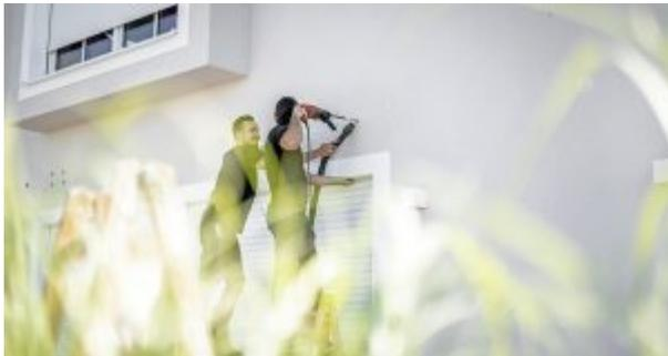
Nicht selten müssen an einer gedämmten Fassade Markisen oder andere Gegenstände angebracht werden. Gerade bei Markisen kommt einiges an Gewicht zusammen. Hier müssen die richtigen Befestigungsmittel gewählt werden, um einerseits die statischen Anforderungen zu erfüllen und andererseits den Wärmeschutz nicht zu beeinflussen. Auch darf die Befestigung von Anbauteilen nicht dazu führen, dass Feuchtigkeit in die Konstruktion gelangt.
