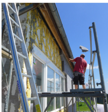
Abschälen des Dämmstoffs
