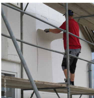
Strippen der Putzschicht
