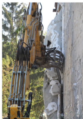
Teilselektiver Rückbau
