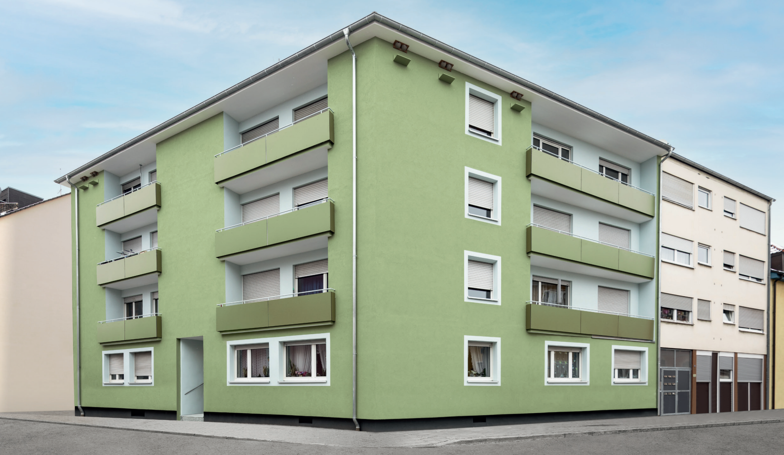
Abb. 5: Loggien in einem mehrgeschossigen Gebäude
