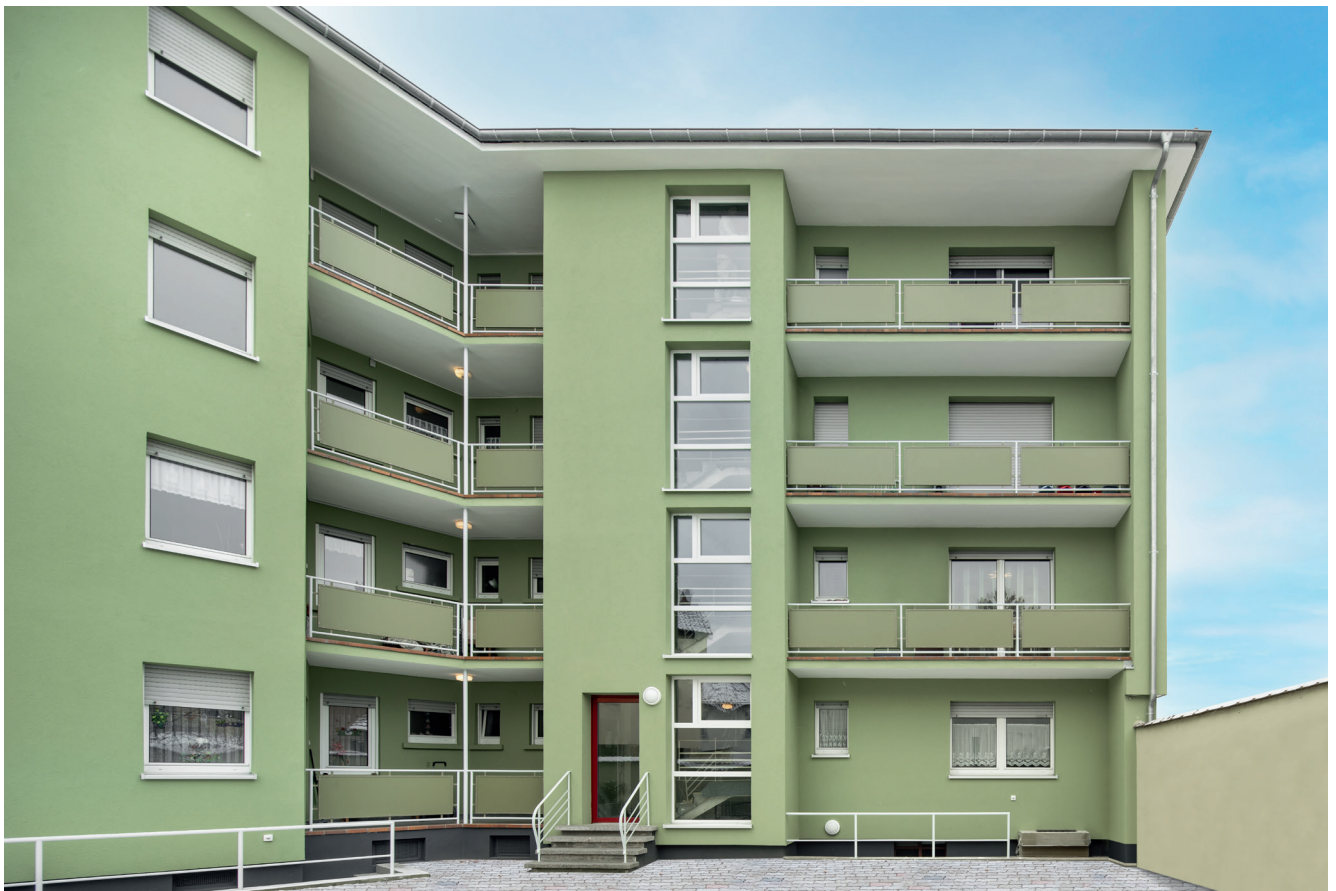
Abb. 11: Nach außen offener C-förmiger Querschnitt von Laubengängen
