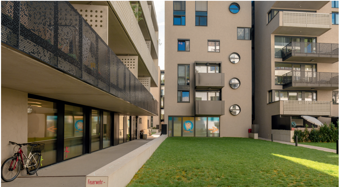
Abb. 12: Nach außen offener C-förmiger Querschnitt von Arkaden
