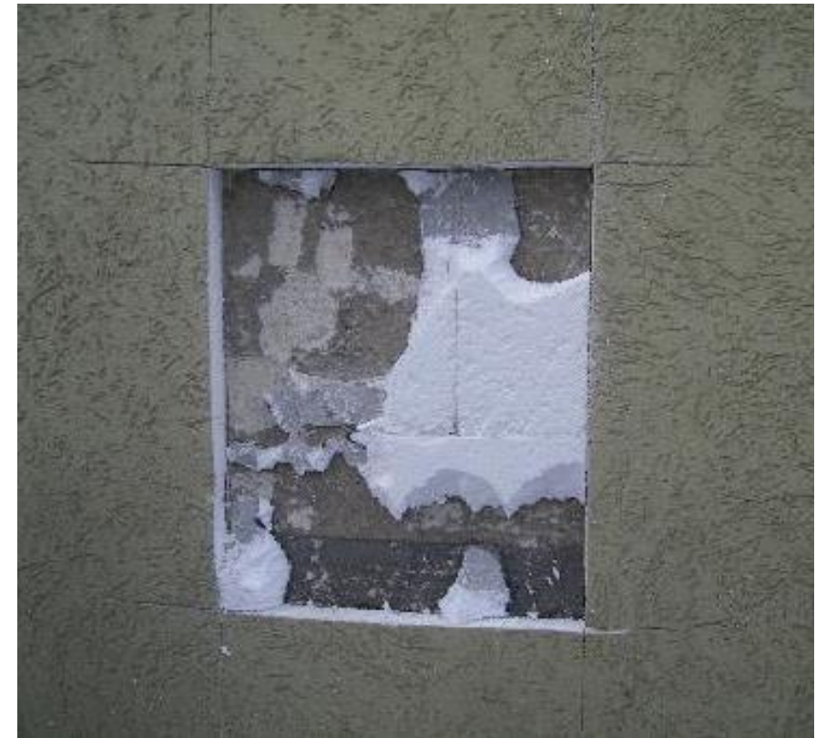
Fassadenöffnung, Größe z.B. 1 x 1 m
