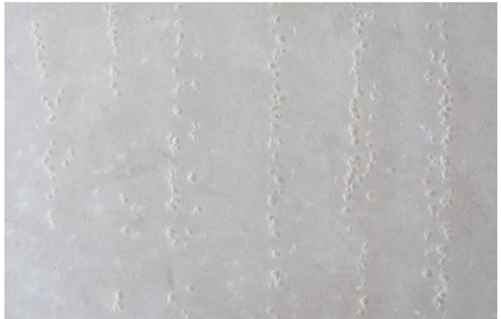
Abb. 19: Beispiel für die Bläschenbildung an der Oberfläche von Fließestrichen
