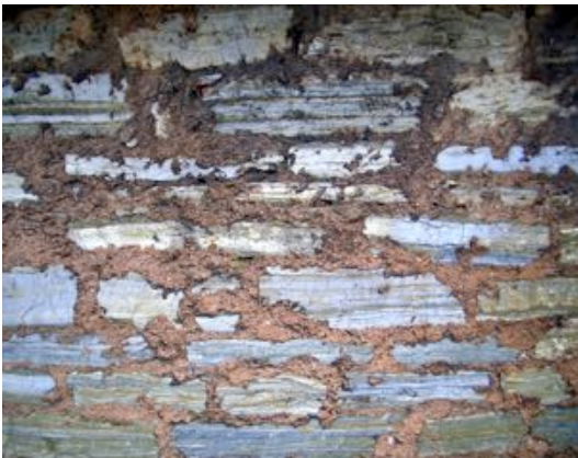
Gipsmauerwerk an einer Scheune in Kleinbartloff (Thüringen)
