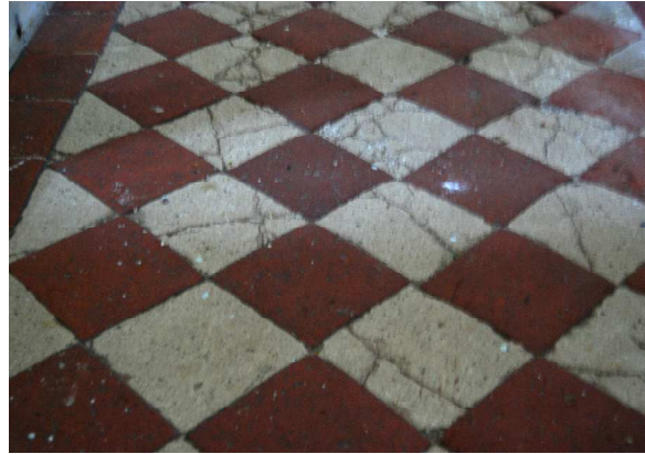
Abb. 3 / 4: Gipsestrichfußboden zwischen Keramikfliesen gegossen in der Dorfkirche Eschenbergen bei Erfurt
