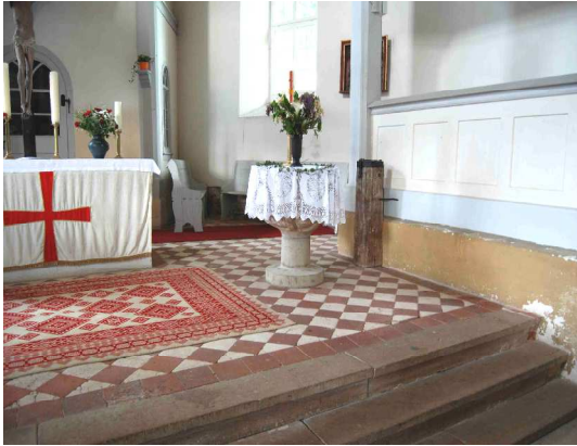
Abb. 3 / 4: Gipsestrichfußboden zwischen Keramikfliesen gegossen in der Dorfkirche Eschenbergen bei Erfurt
