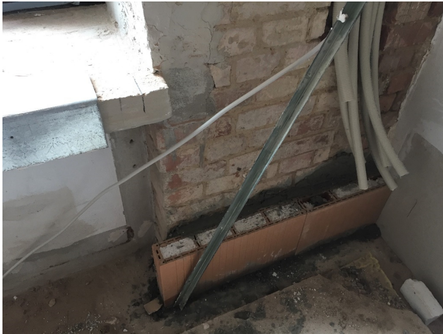
Kontrolle der Ausführung bei Innenwärmedämmungen
