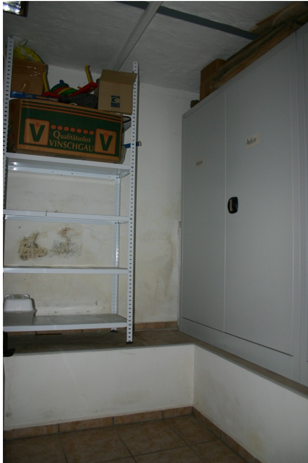
Durchfeuchtete Bereiche einer Kelleraußenwand
