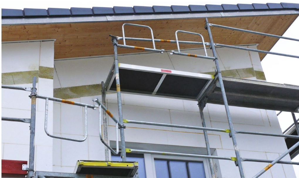
1 Abschlussriegel an »brennbares« Schrägdach.
