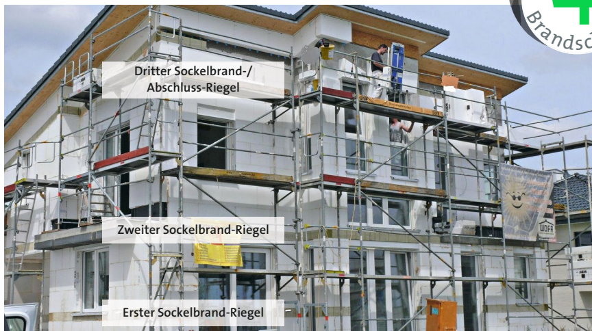
2 Bei Ein- oder Zweifamilienwohnhäusern entfallen meist mangels Gebäudehöhe die Raumbrandriegel – deren Schutzfunktion werden, wie auch beim Abschlussriegel, durch die Sockelbrandriegel mitübernommen.
