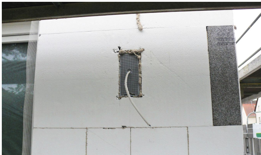
1 In das Wärmedämm-Verbundsystem integrierte Elektroinstallation.
