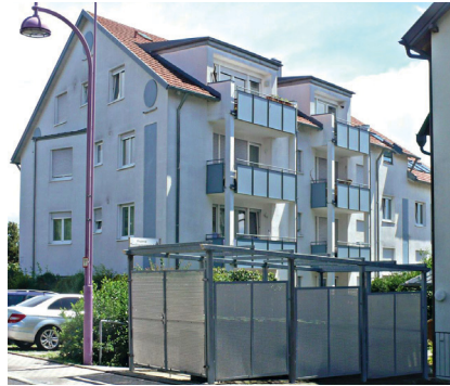
2 Empfehlenswerte Müllcontainer-Einhausung. Fotos: FV WDVS
