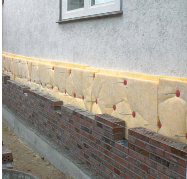
Energetische Gebäudesanierung mit Wärmedämmung und Verblendmauerwerk.
