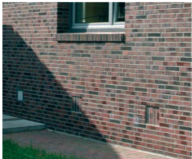
Energetische Gebäudesanierung mit Wärmedämmung und Verblendmauerwerk.
