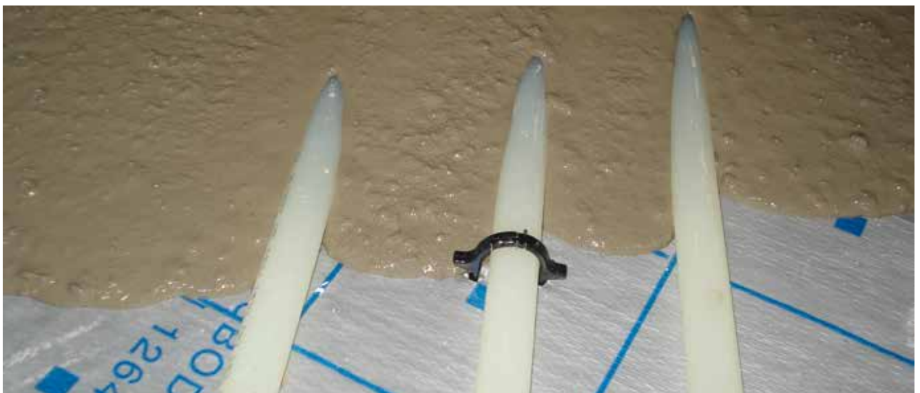
Abb. 2: Optimale Wärmeübertragung: Fließestrich über Heizrohr nach einer Stunde Vorlauftemperatur bei 45 °C
