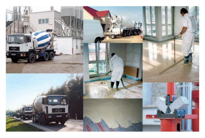
Der Estrich ist das mit am meisten beanspruchte Bauteil eines Gebäudes. "Zeitlebens" muss er extremen Belastungen standhalten: Temperaturschwankungen, Druckbelastungen, Gebäudebewegungen und unterschiedlichen Nutzungseinflüssen.
