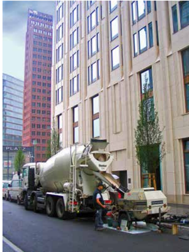
Abbildung 9: Anlieferung von Fließestrich als Werk-Frischmörtel mit dem Fahrmischer; Bildquelle: Schwenk Zement)
