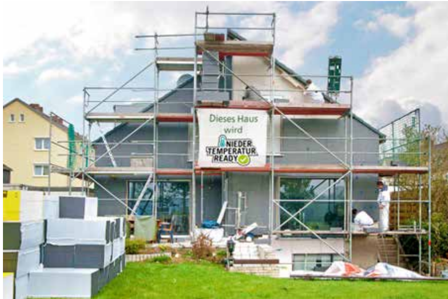
Abbildung 21: Verarbeitung eines Wärmedämm-Verbundsystems; Bildquelle: Knauf Gips KG
