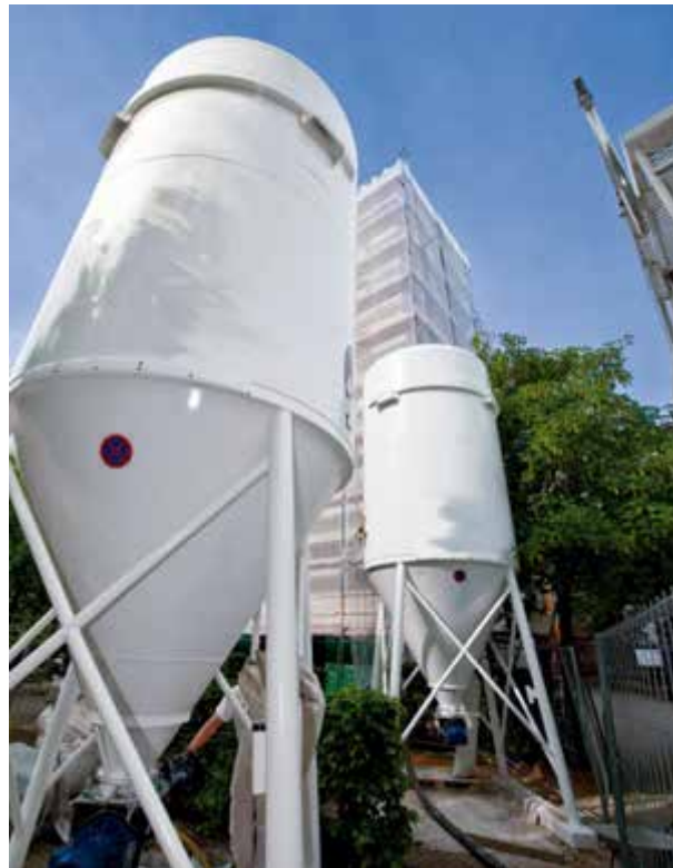
Abbildung 8: Trockenmörtelsilos auf der Baustelle; Bildquelle: Caparol)
