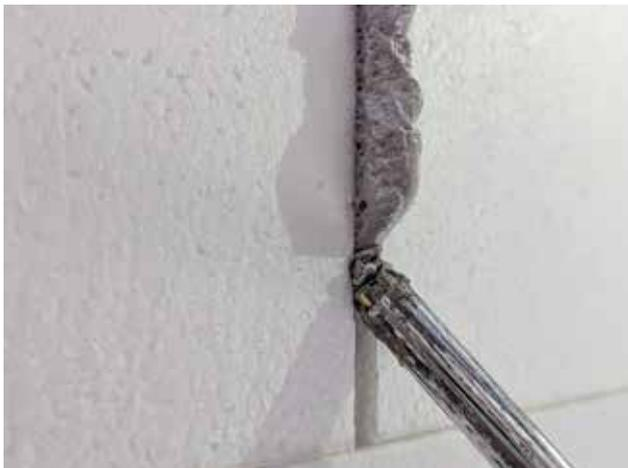
Bild 5: Beispielhafte Verfüllung einer Dämmplattenfuge
