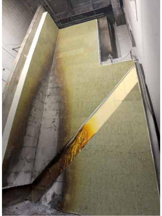
Bild 29: Brandschädigung (mit Putzsystem / nach Entfernung des Putzsystems)
