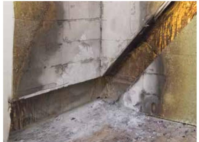
Bild 30: Brandschädigung im Spritzwasserbereich (nach Entfernung des Putzsystems)
